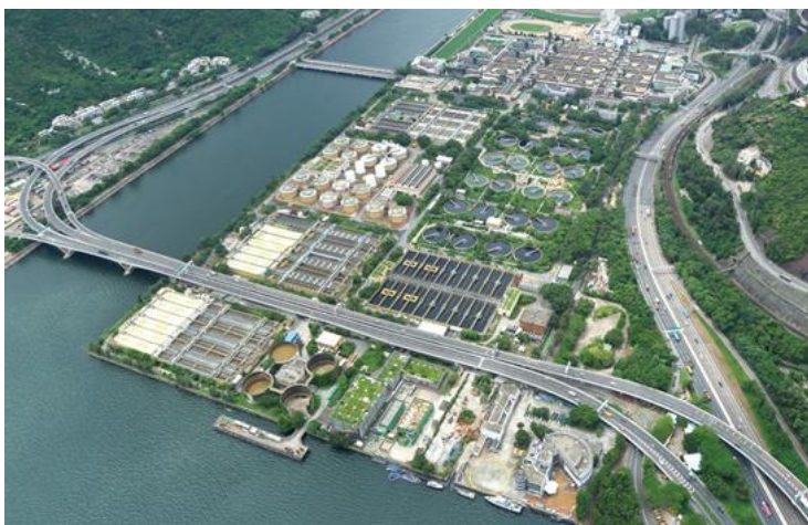
圖 3.6 沙田污水處理廠 來源：渠務署
