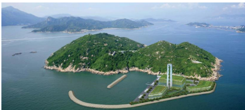
圖 5.3 位於石鼓洲旁的綜合廢物管理設施合成照片 來源：摘自立法會參考資料摘要(2011) - 發展綜合廢物管理設施
