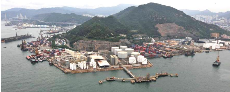
圖 6.4 青衣南石油氣 / 油庫
