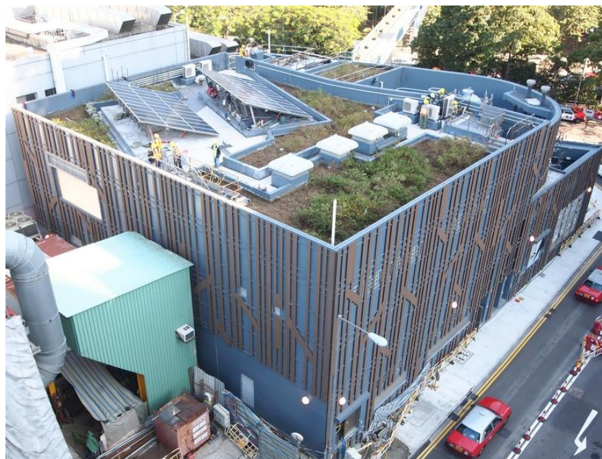
圖 2.5 灣仔新海水抽水站 來源：土木工程拓展署
