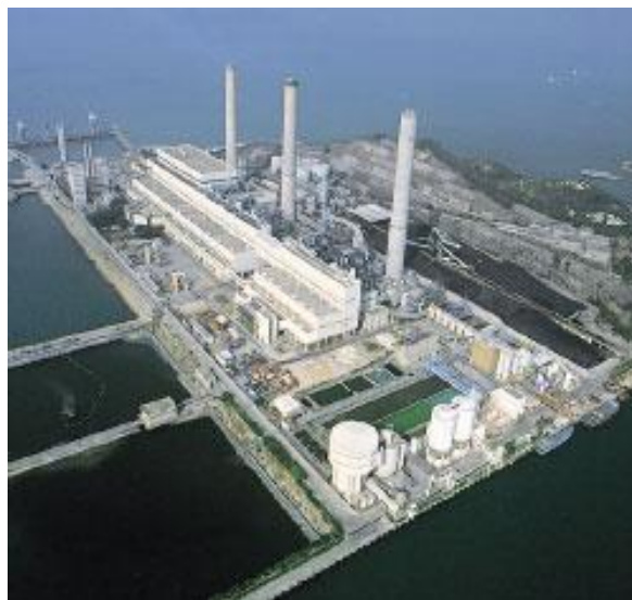
圖 6.1 南丫發電廠 來源：環境保護署
