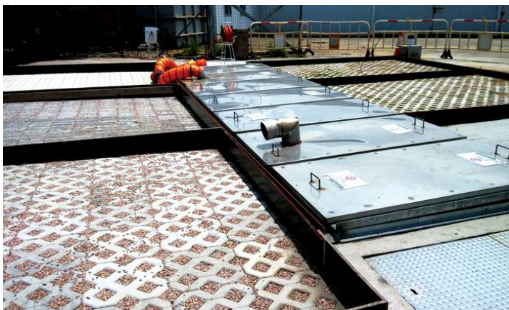
圖 4.4 昂船洲污水處理廠的多孔透水路面 來源：渠務署
