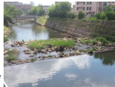
圖 4.7 用天然物料建造的 的西貢蠔涌河魚梯 來源：渠務署
