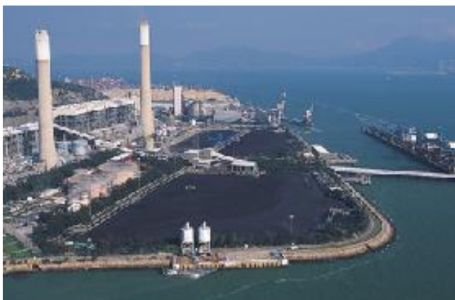
圖 6.2 青山發電廠 來源：環境保護署
