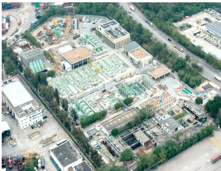
圖 3.3 改善後的望后石污水處理廠 來源：渠務署
